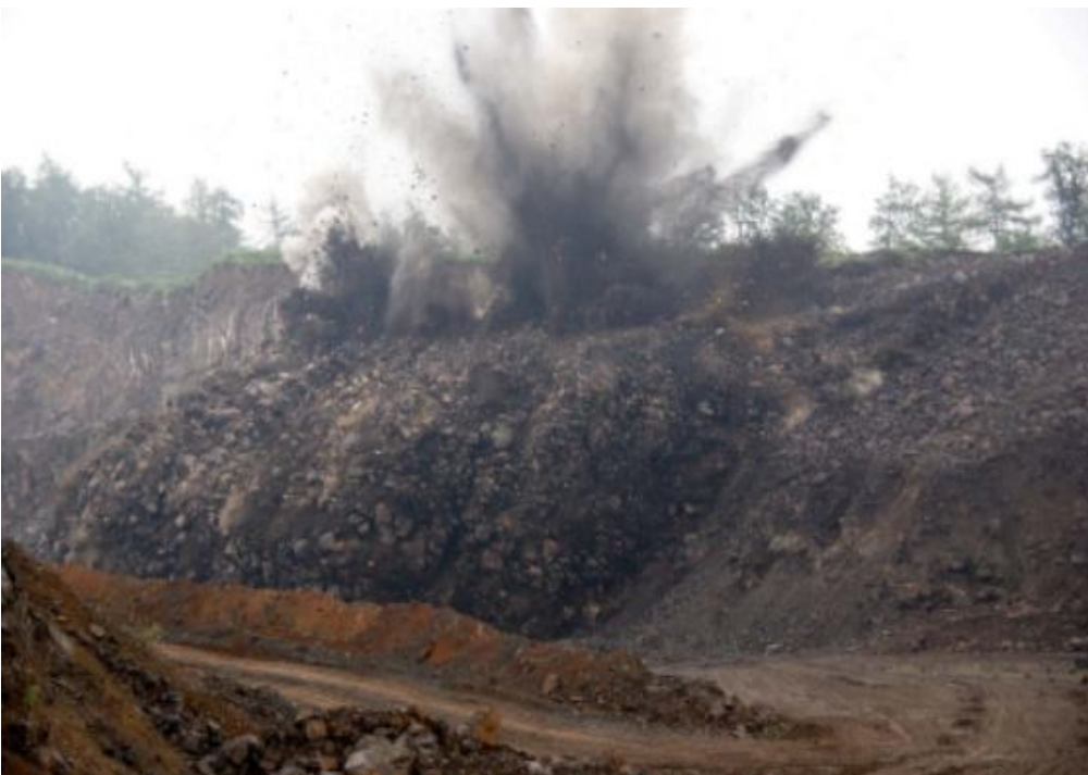
Foto č.14 - Trabice - průběh clonového odstřelu jižní lomové stěny ve východní polovině třetí etáže - rozvolnění bloků hornin (bibliografický zdroj č.6)
