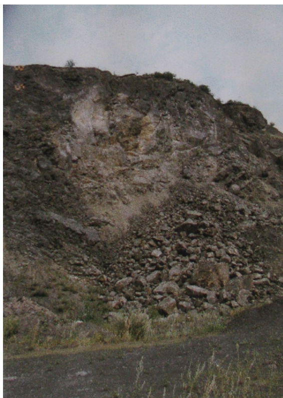
Foto č.44 - Lysec - lomová stěna, 1998 (bibliografický zdroj č.13)
