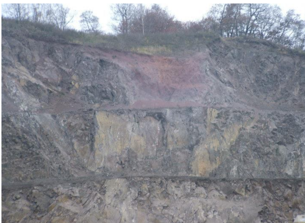
Foto č.2 - Kubačka - sesuv horniny na nejvyšší etáži Autor: Jan Vincenc, říjen 2011
