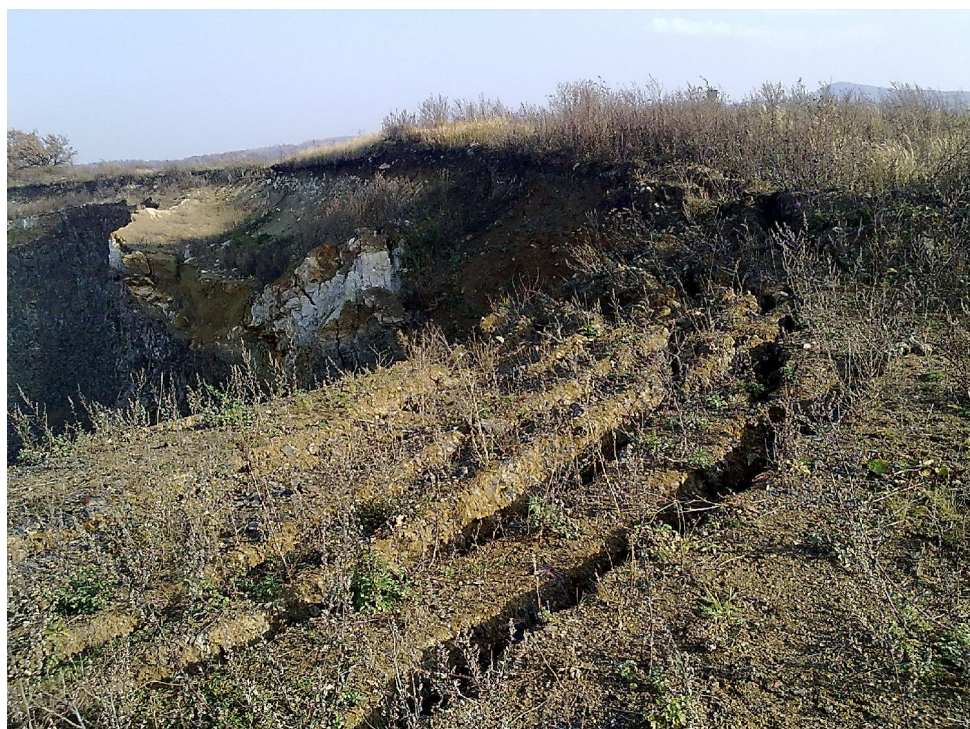
Foto č.36 - Stříbrník - narušení vrchní partie lomové stěny jižního okraje kamenolomu Autorské foto, listopad 2011
