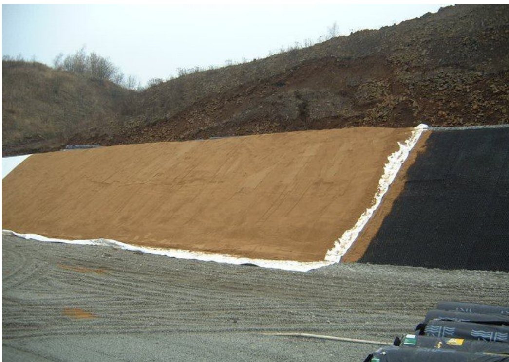
Foto č.91 - Holý vrch - zpevnění stěn prostoru skládky www.ekovolfartice.rajce.idnes.cz/skladka
