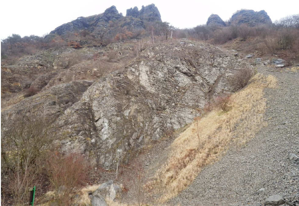
Foto č.108 - Kozí vrch - opuštěný lom Autorské foto, leden 2012
